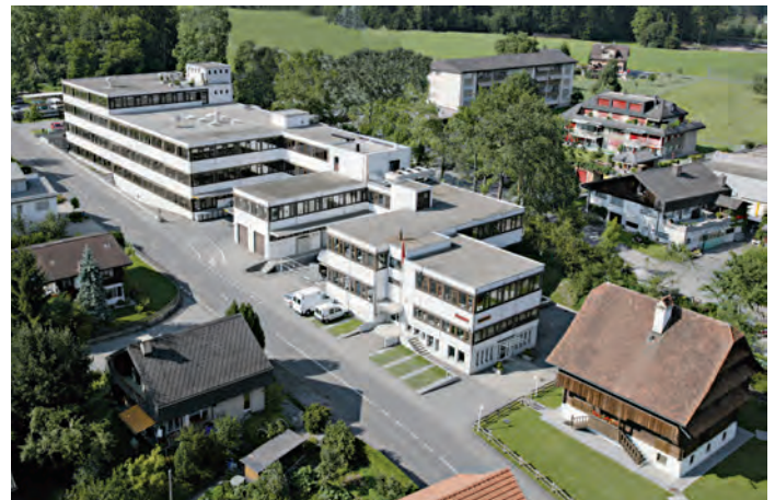
Leister Technologies AG, производственное здание, Кегисвиль, Швейцария
