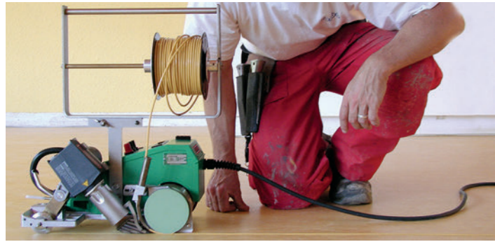
Сварка напольных покрытий сварочным автоматом Unifloor E
