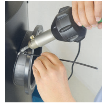
Аппарат TRIAC ST: сварка трубы с помощью насадки быстрой сварки
