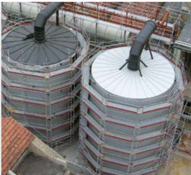
Система очистки воздуха, Испания. Материал ПЭНД
