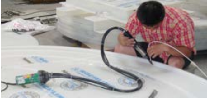
Вентилятор MINOR подаёт воздух на DIODE PID
